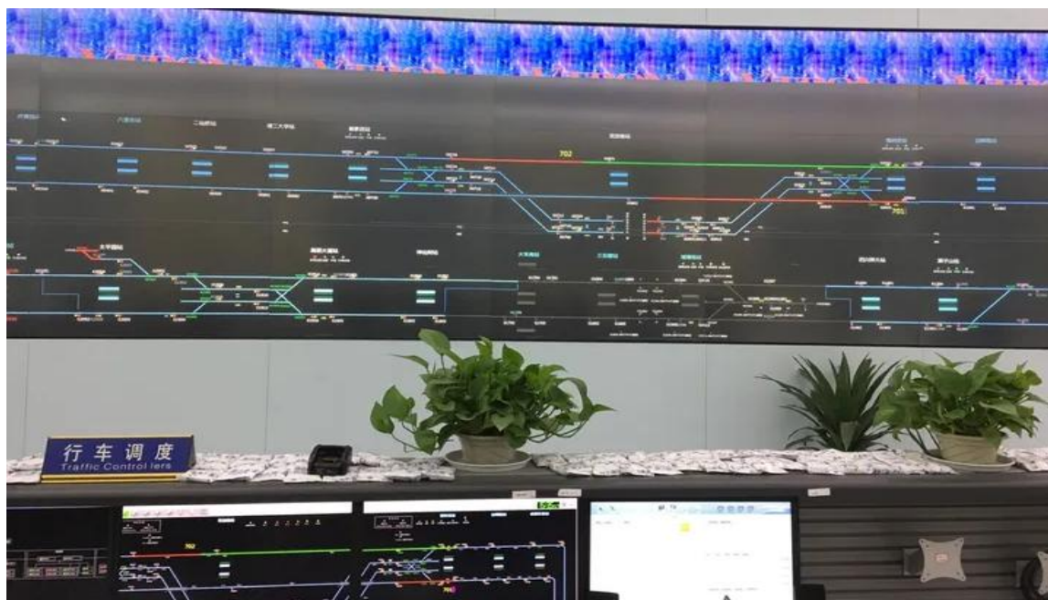
图 3-6-20 轨道交通调度中心
